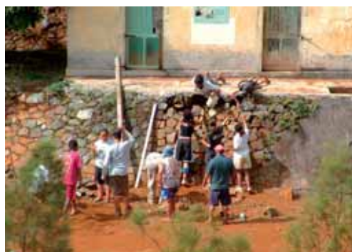
Restauration de la paroi du monticule qui sert de soubassement au bureau de surface.
